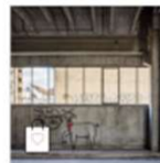
Unterzug Stahlbeton / I- Träger 9.20m
