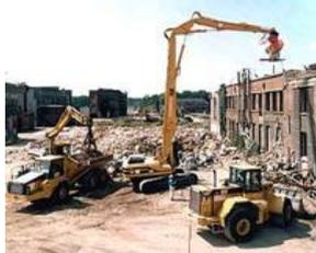
Bei Gebäuden bzw. Gebäudeteilen mit Baujahr vor 1990 soll vor Beginn von grösseren Abbruch- oder Demontagerbeiten eine geeignete Fachperson in sämtlichen Räumen eine Gebäudevoruntersuchung (Gebäudecheck) auf Asbest, PCB (Fugendichtungsmassen) und PCP (Holzschutzmittel) durchführen. Geeignete Fachpersonen müssen nachweislich über mindestens 3-jährige Erfahrung bei Gebäudevoruntersuchungen verfügen.
