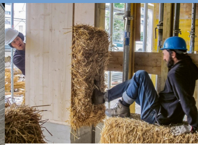
Isolation d'un mur avec bottes de paille, Genève (Photo: ATBA Architecture+Energie)
