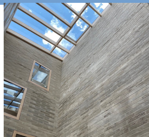
Parois intérieures avec briques Terrabloc, Lausanne (Photo: Cornaz SA)
