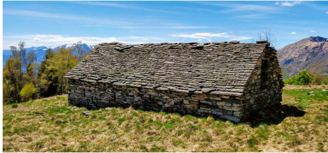
Gebäude wie dieses hier im Verzascatal wurden von Hand mit Steinen und Holz aus der Umgebung gebaut. Es verursachte für seine Erstellung keinerlei CO 2 -Emissionen. Bild: Severin Lenel
