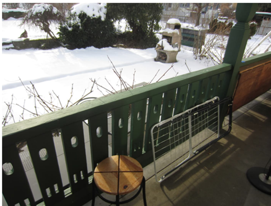
Illustration 1 : Utilisation fréquente de peintures au plomb en cas de supports bois exposés aux intempéries (Photo : Stephan Baumann, bafob GmbH)
