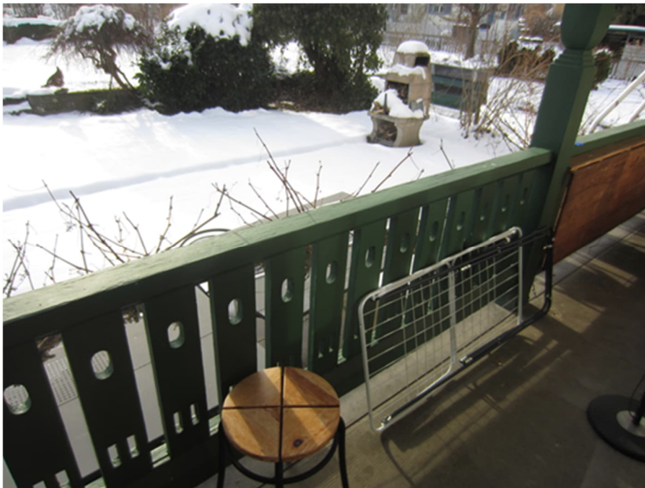
Illustration 1: Utilisation fréquente de peintures au plomb en cas de supports bois exposés aux intempéries (Photo : Stephan Baumann, babob GmbH)
