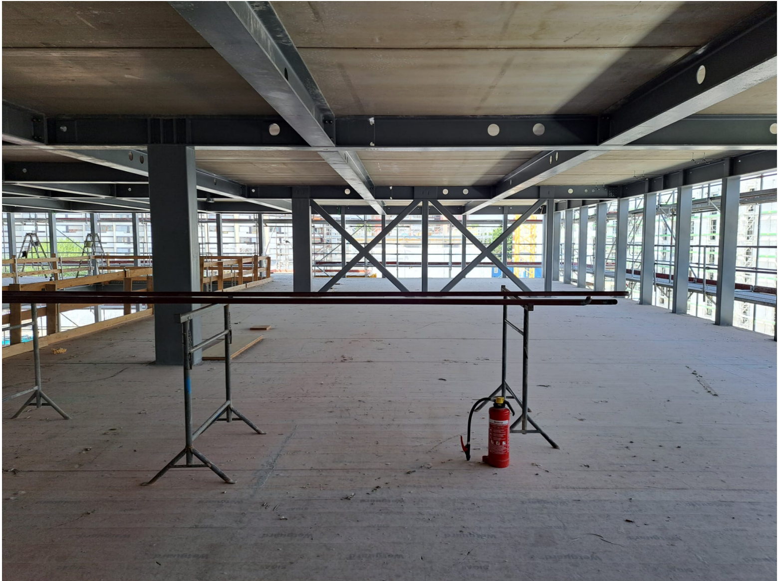
Structure à l'étage, béton, bois et acier
