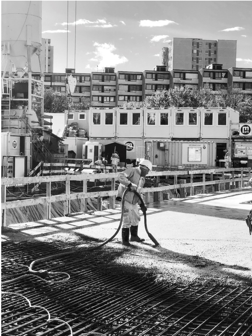
Bétonnage dalle RDC et armature Noyaux
