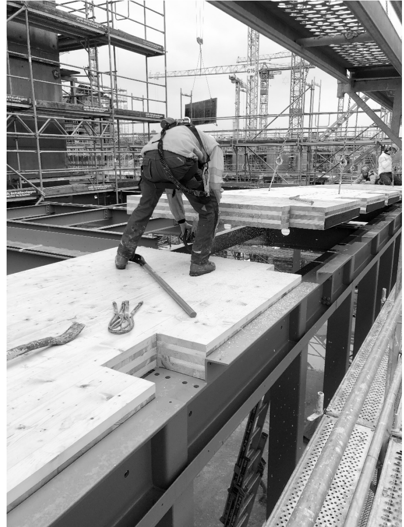
Cascade d'escalier et montage des dalle/palque en CLT
