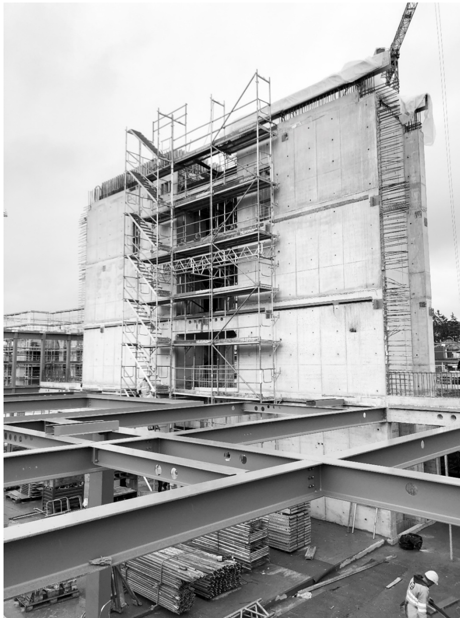
Noyaux en béton armé 1° Étape
