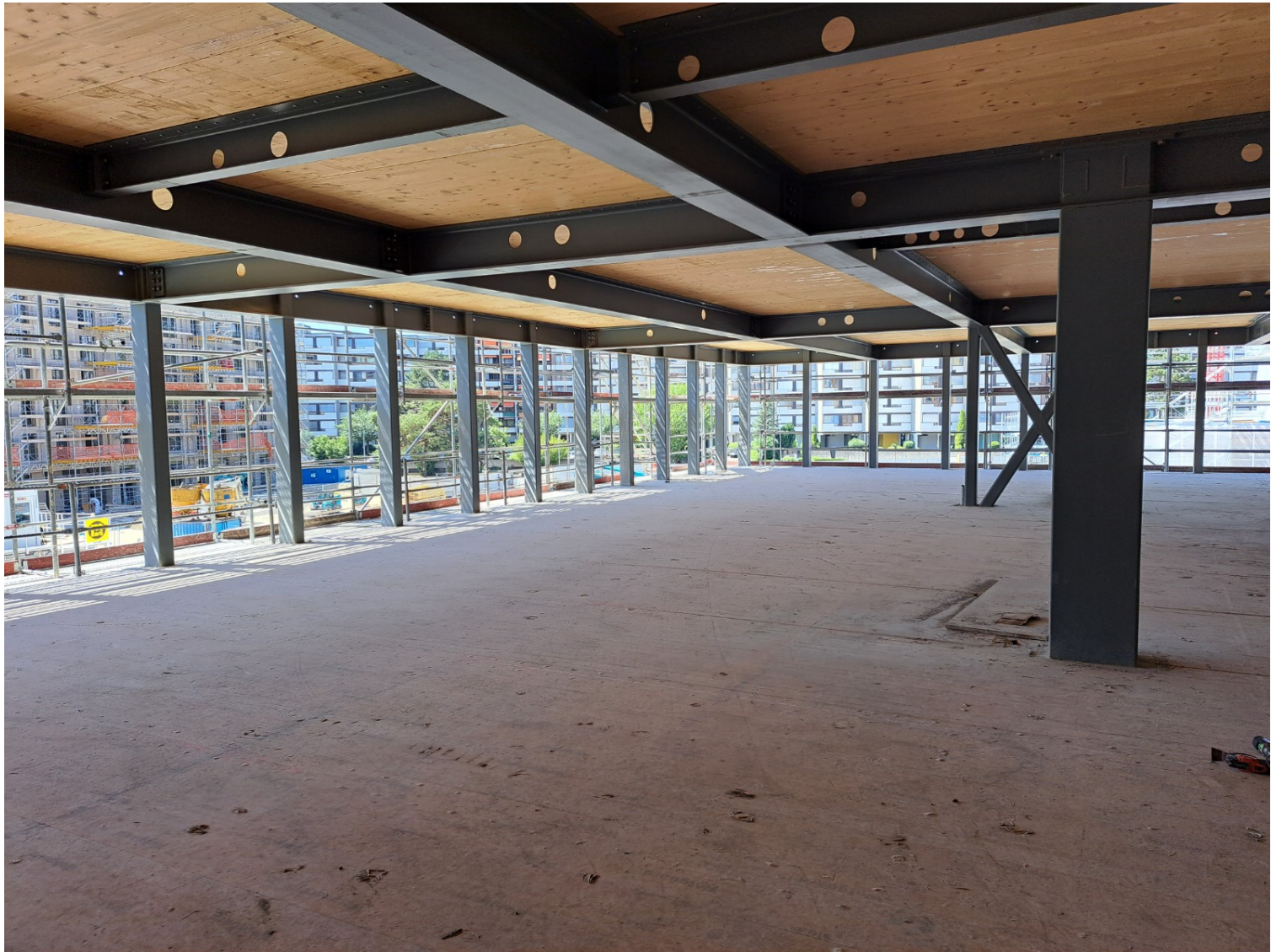
Structure à l'étage, béton, bois et acier
