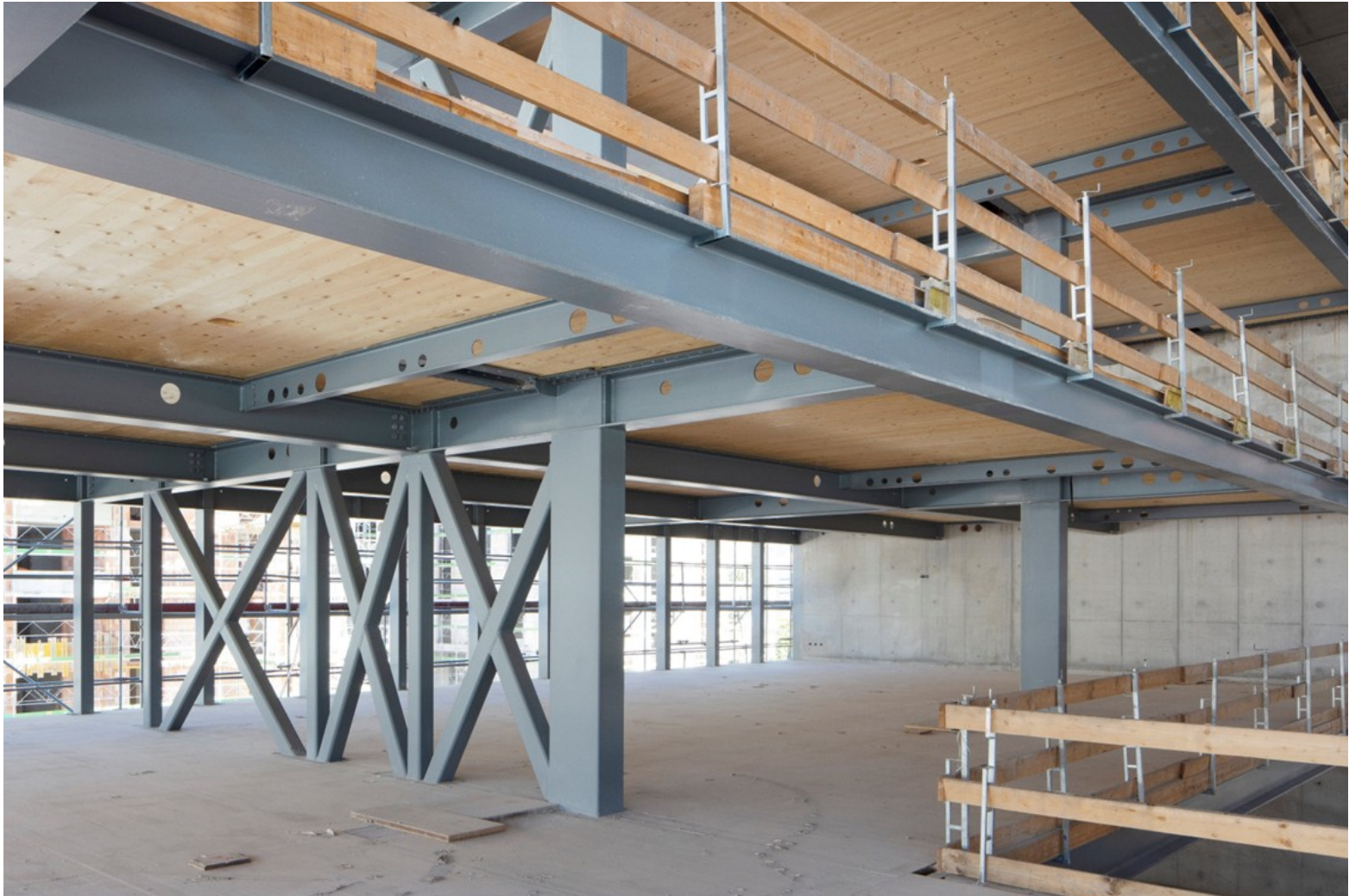
Structure à l'étage, béton, bois et acier
