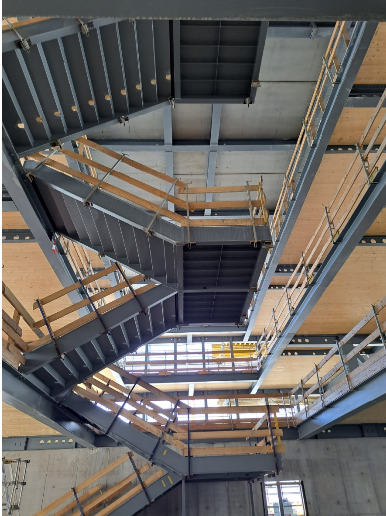
Cascade d'escalier et montage des dalle/palque en CLT
