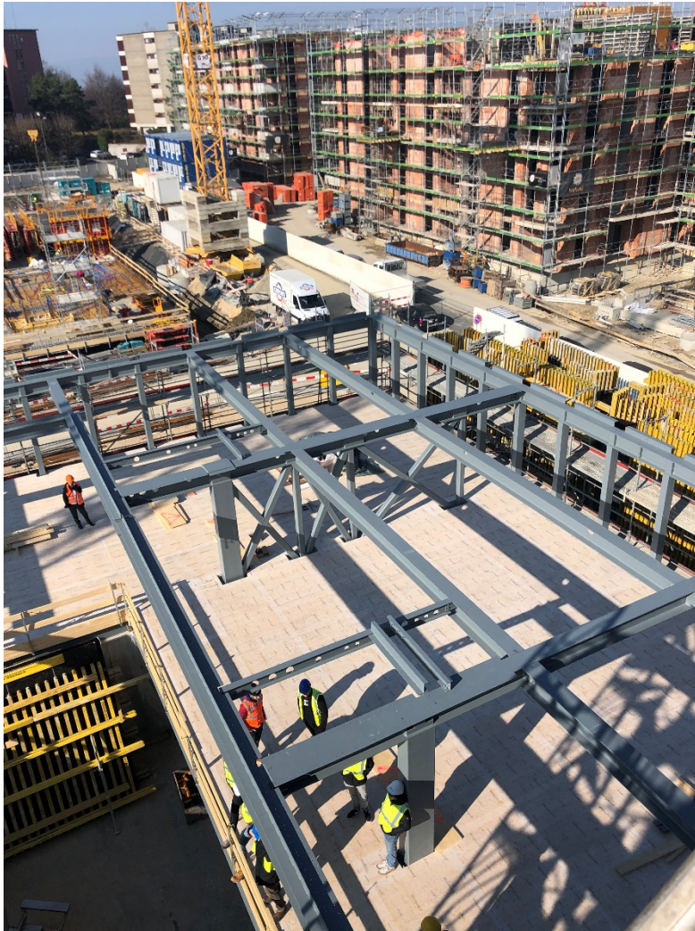
Structure à l'étage, charpente métallique
